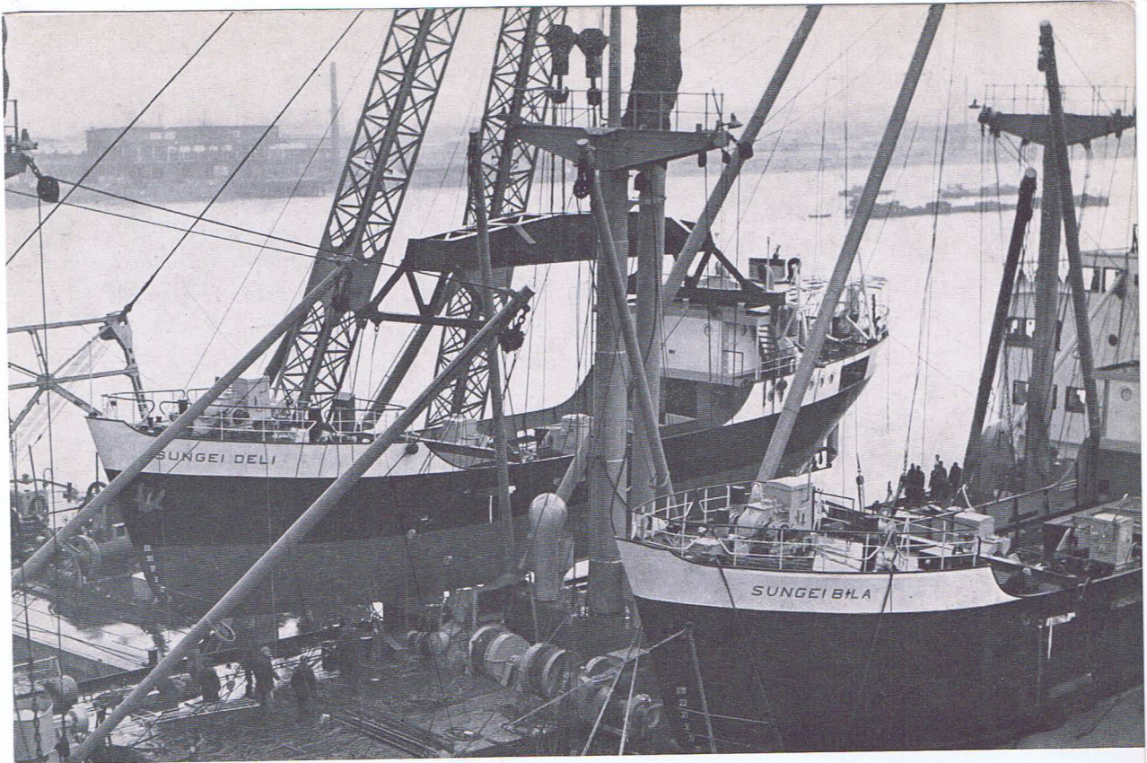
In 1950 zijn twee coasters, gebouwd op de werf De Vooruitgang, en twee coasters, gebouwd op de werf Stapel te Spaarndam, alle vier bestemd voor de Koninklijke Paketvaart Maatschappij, en voorzien van Industriemotoren per Modjokerto naar Indonesië verscheept. Op de foto: twee kustvaartuigen worden met een bok op het dek van de oceaanstomer gezet.
