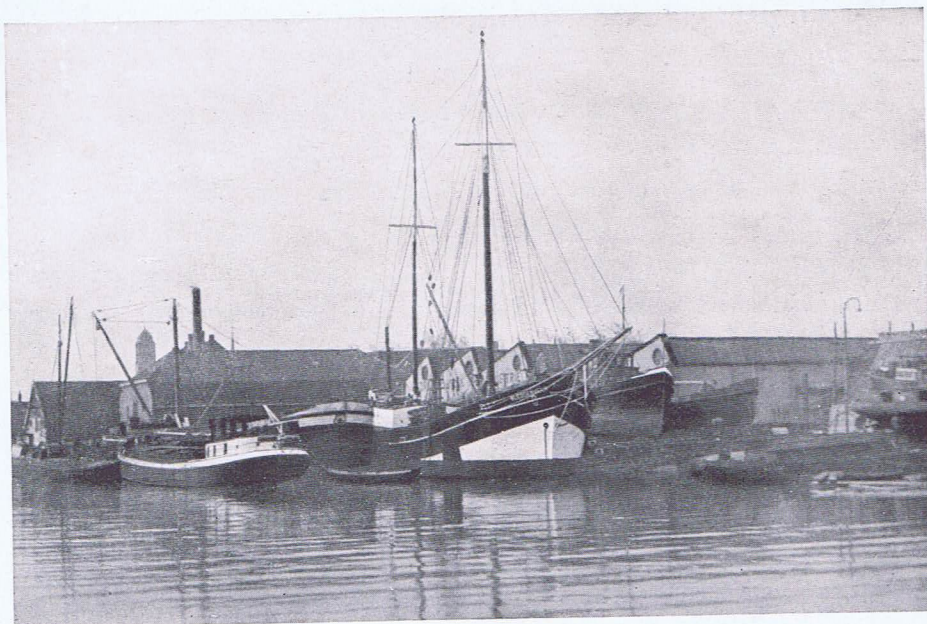
Reparatiewerf en motorenfabriek waren in de jaren twintig volop met werk bezet.
