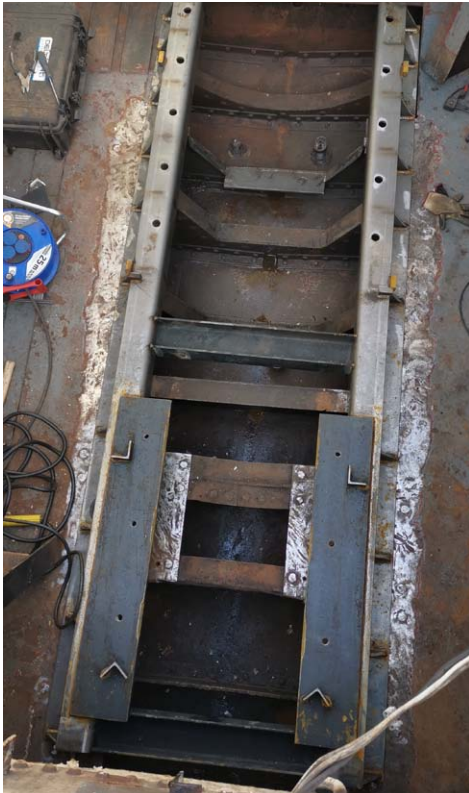
De fundering erin en dan de Brevo op zijn plek. De passtukjes op de fundering maken het makkelijk: uitlijnen op de schroefas en vastplakken die handel
